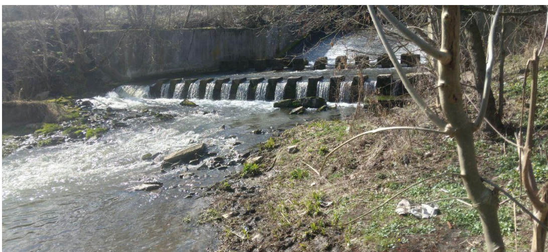
Гідротехнічні споруди (дамба) Борсуківського водосховища
