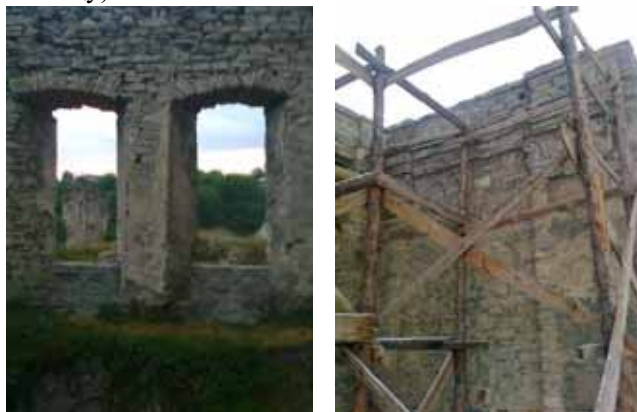
Фото 15. Ремонтно-реставраційні роботи в замку
