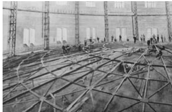
Іл. 2. Будівництво одного з газометрів
