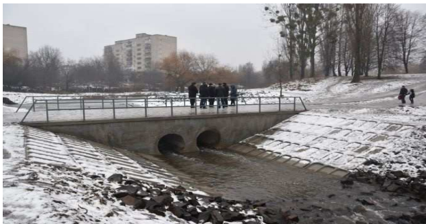
Відремонтвана гідротехнічна споруда (мостовий перехід з шлюзовою камерою) біля входу в парк імені 900-річчя м. Луцька
