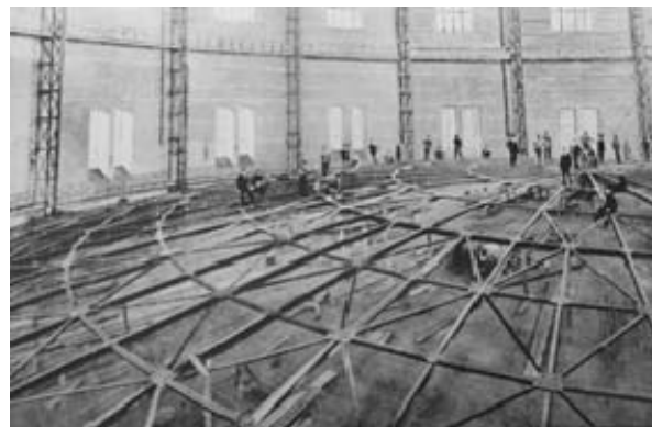
Іл. 2. Будівництво одного з газометрів
