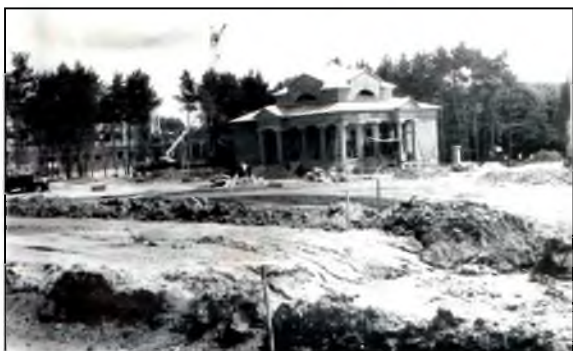
Рис. 4. Будівництво вхідної зони з вул. Київська у розпалі (початок 90-років)
